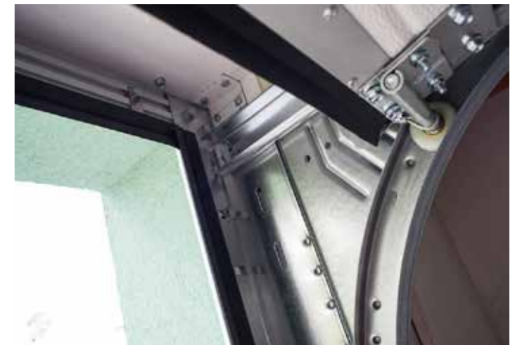
▲ RSV; Detail des Rahmens und der Laufschienen
